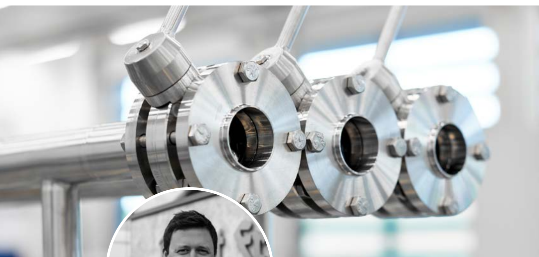
Die Schnittstelle zur KEG-Linie, sozusagen die letzte manuelle Absperrmöglichkeit, bevor es in die Anlage geht
